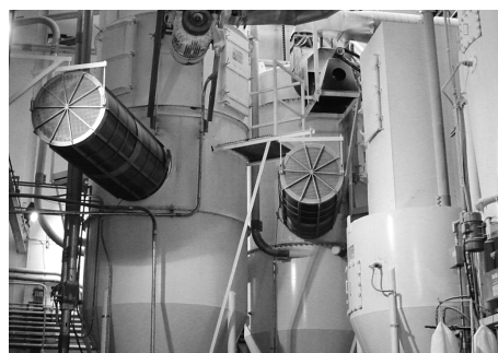
写真6 フレームレス爆発放散口のサイクロンへの設置例
