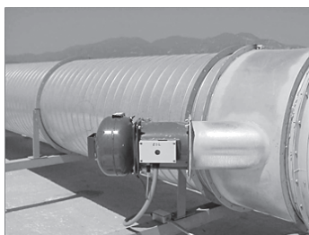
図10 直径900mmの配管に消火剤によるしゃ断バリア
