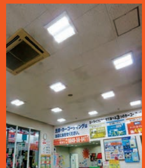
店内照明 LED設置工事
