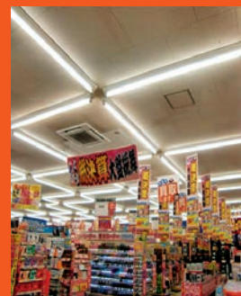
店内照明 LED設置工事
