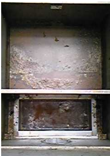
A (第1槽・第2槽)
