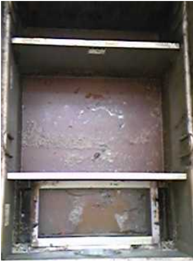
A (第1槽・第2槽)
