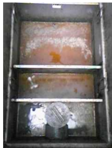
C (第2槽・第3槽・第4槽)
