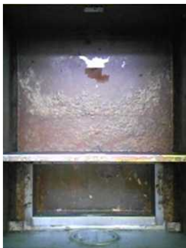
A (第1槽・第2槽)
