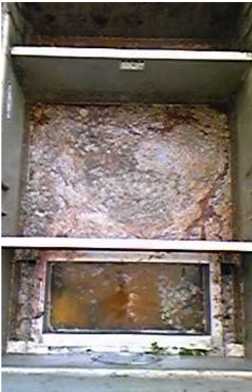
A (第1槽・第2槽)
