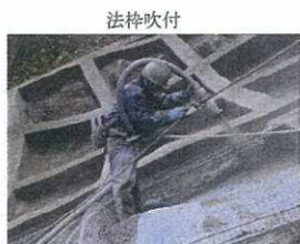
【法枠吹付】 法枠組立完了後にセメント・水・砂を ベースに練り混ぜホースで圧送し吹付ける。
