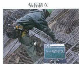
【法枠組立】 金網設置完了後、鉄筋及び フレームを組立てる
