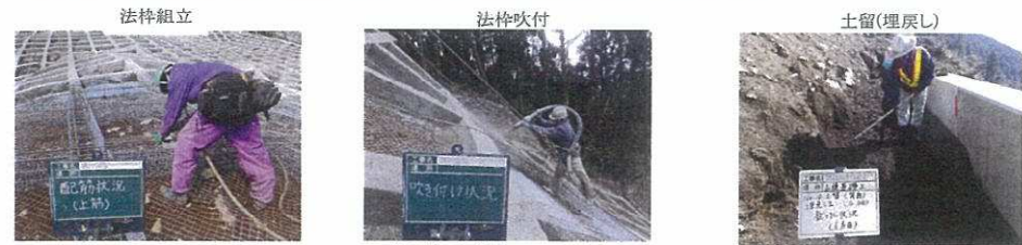
【法枠組立】 金網設置完了後、鉄筋及びフレームを組立てる
