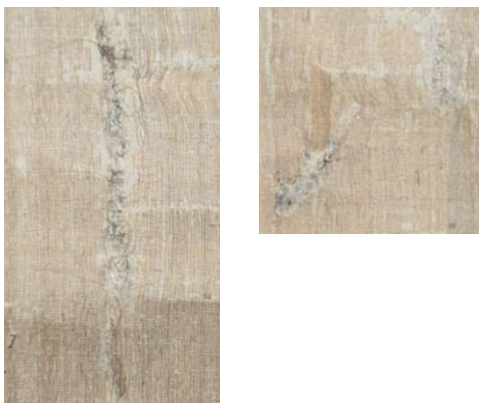
写真7 賛文による補修の可能性のある部分
